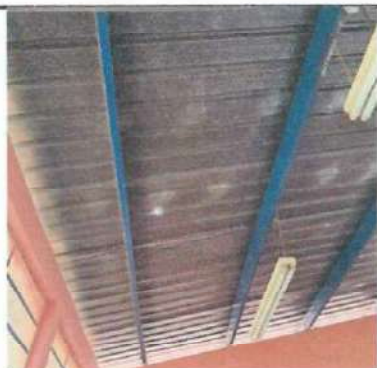
Foto 3: Se observa que la estructura de techo presenta deterioro y la lamina esta picada por lo que será sustituida en su totalidad
