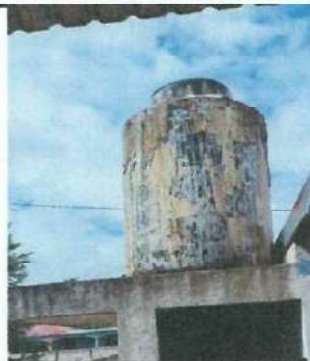
Foto 6: Es necesario sustituir el finaco ya que esta deteriorado y es necesario para uso en la cocina del establecimiento
