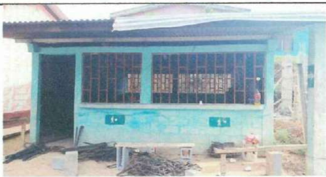
Foto 5: tanto la estructura, techo, ventanas y puerta de la cocina necesitan sustitucion por encontrarse en mal estado. Así mismo es necesario pintarla.
